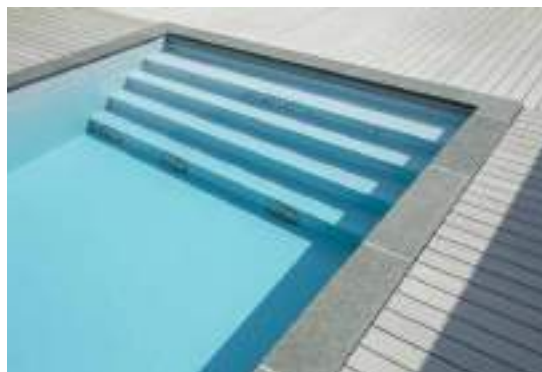
Escalier sur la largeur totale
